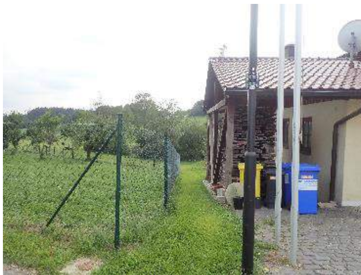
Bild 21: Anwesen Blasiusstraße 20, Ableitung links vom Gebäude
