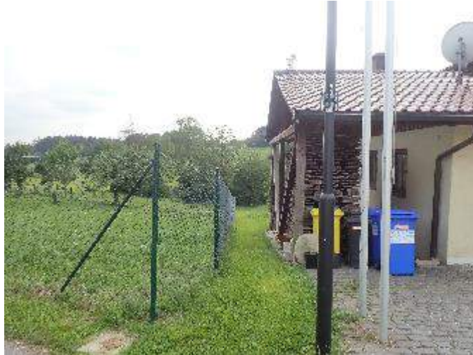
Bild 8: Lichtschacht Blasiusstraße 20, unterhalb Gelände
