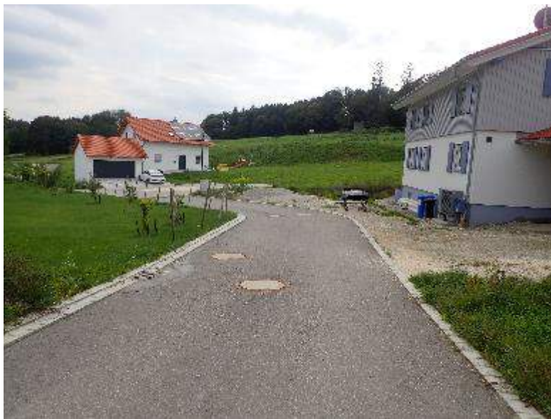
Bild 18: Siedlungsstraße im Wohnhof
