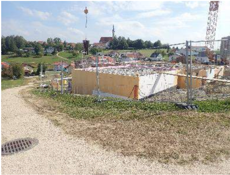
Bild 3: Baugrube - anstehender Boden lehmig, kaum wasserdurchlässig
