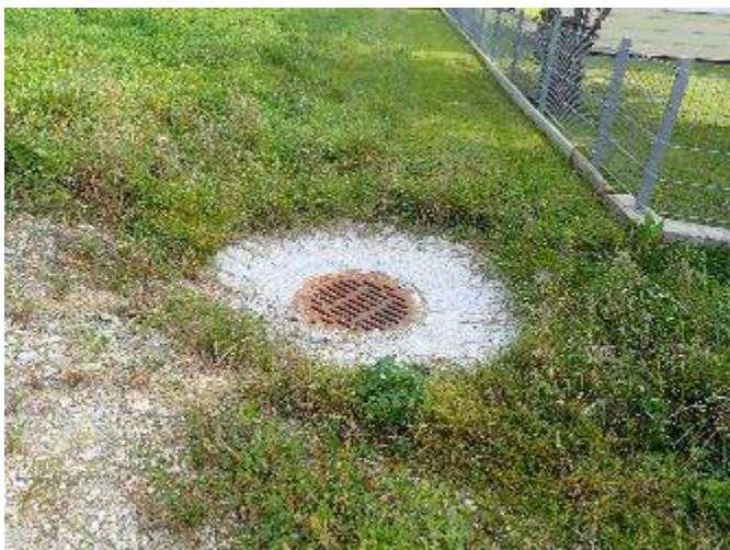
Bild 23: Einlauf Außenfläche Abschnitt 3
