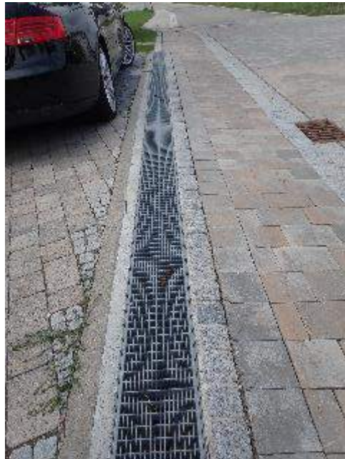
Bild 24: Entwässerungsrinne - Übergang Öffentlicher/Privatgrund
