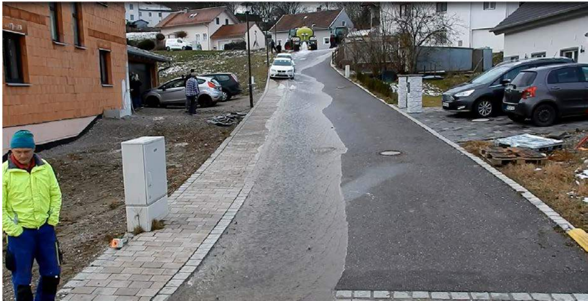
Bild 11: Auslass aus den Wasserbehältern - Wasserlauf in entlang Blasiusstraße - Originalzustand
