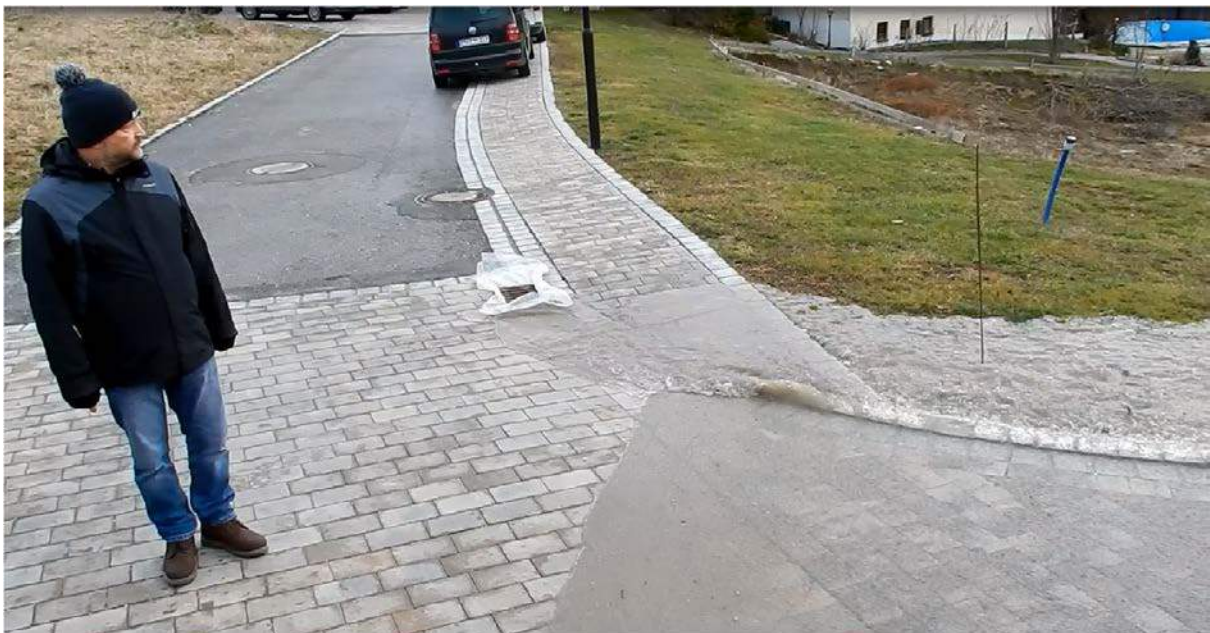
Bild 12: Wasserlauf über die Kreuzung in Richtung Blasiusstraße 20 - Originalzustand
