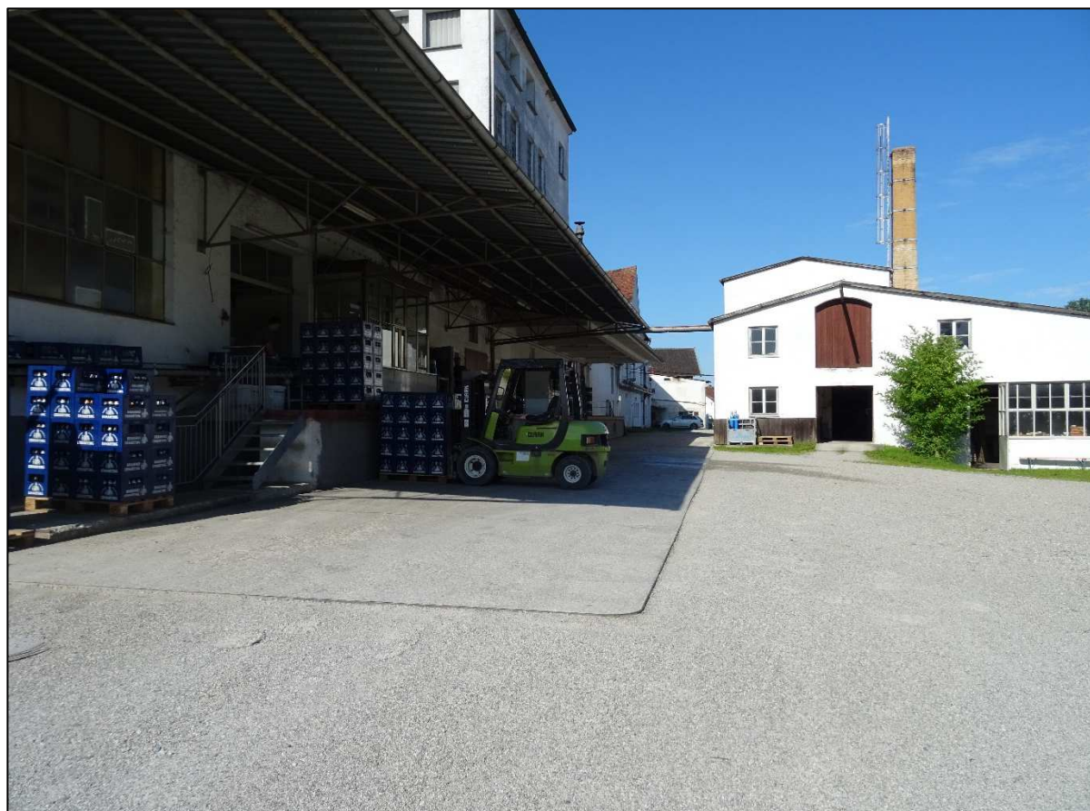
Abbildung 6: Blick nach Westen auf den überdachten Verladebereich
