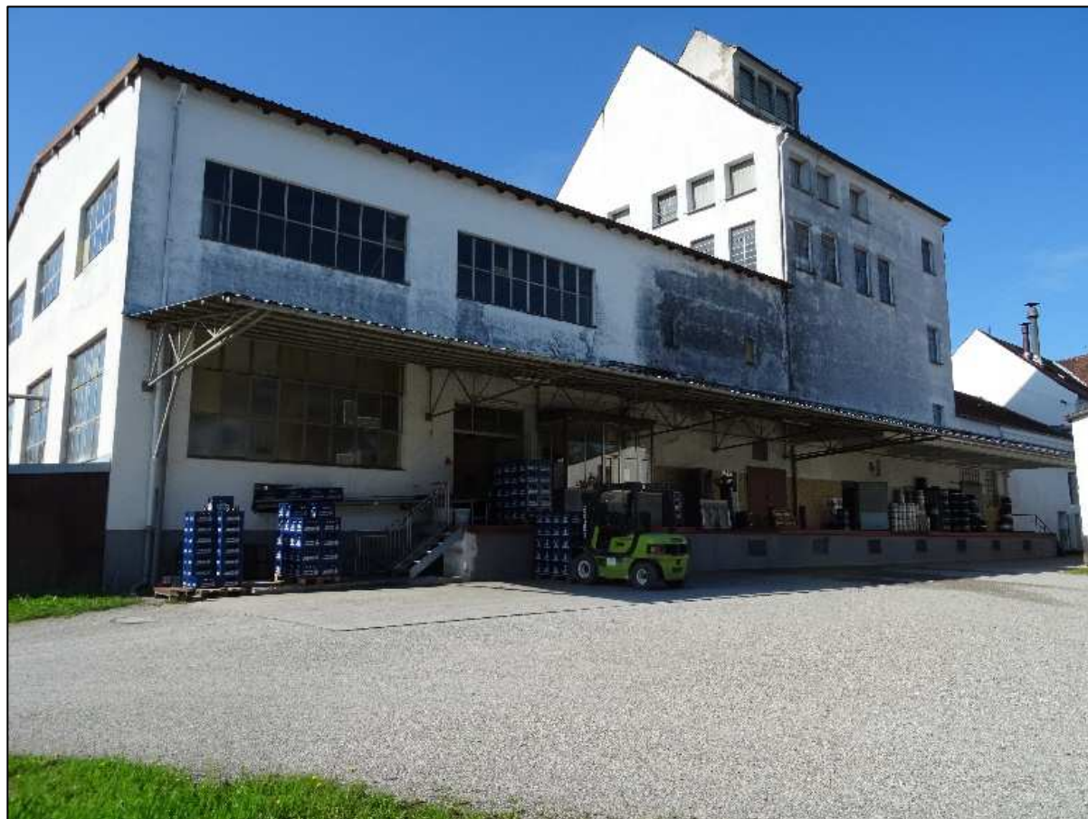
Abbildung 7: Blick nach Süden auf den Verladebereich
