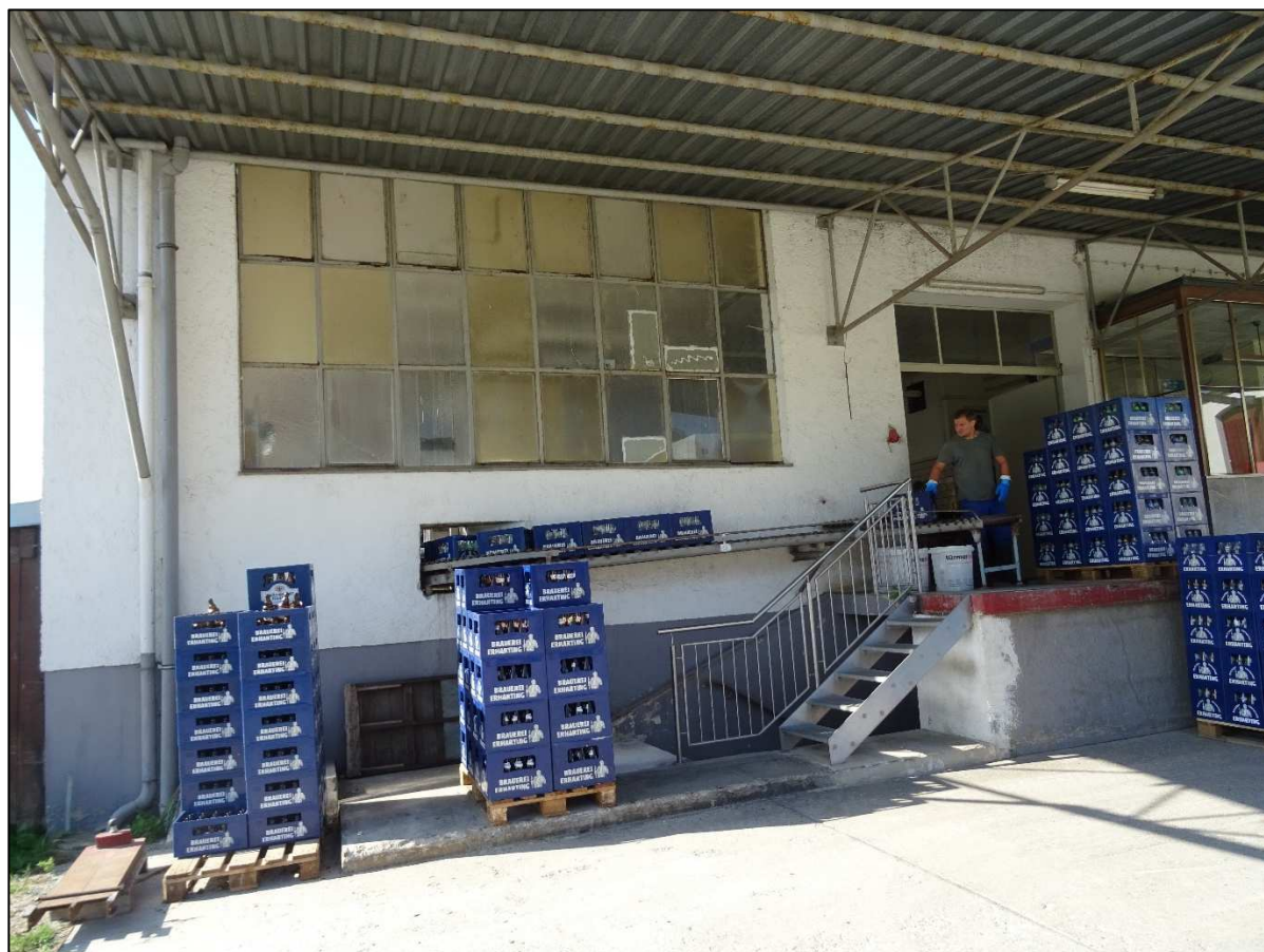
Abbildung 5: Blick auf die Fenster und das Tor in der Nordfassade (f)
