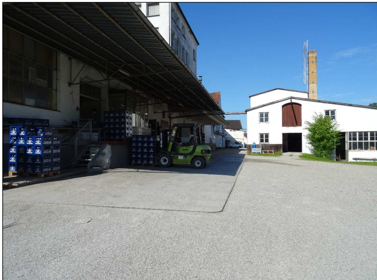
Abbildung 6: Blick nach Westen auf den überdachten Verladebereich
